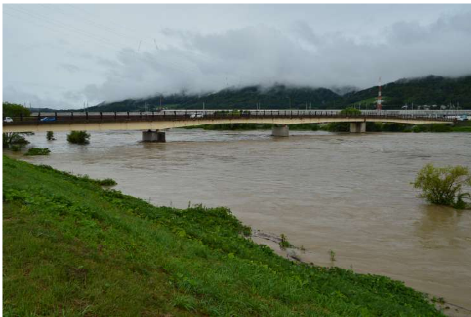
令和3年8月 豪雨による千曲川増水
